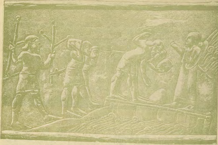
Κατασκευὴ γεφύρας πρὸς διάβασιν ἁμαξῶν.
